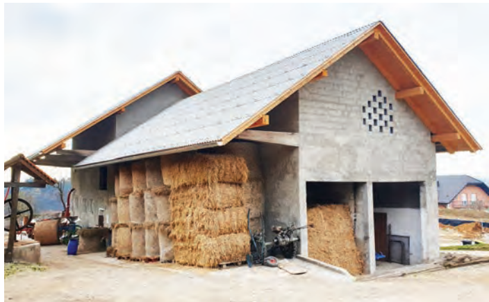
Poslopje po obnovi
